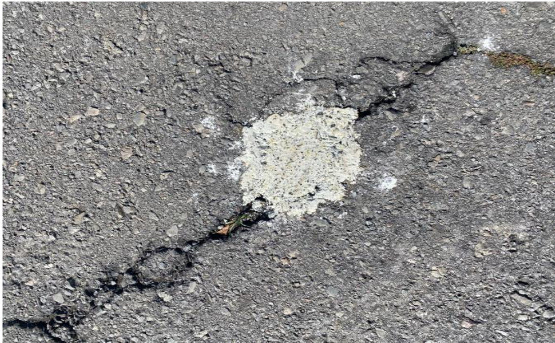
Figura 1. Mezcla de cemento con caucho aplicada a un bache
