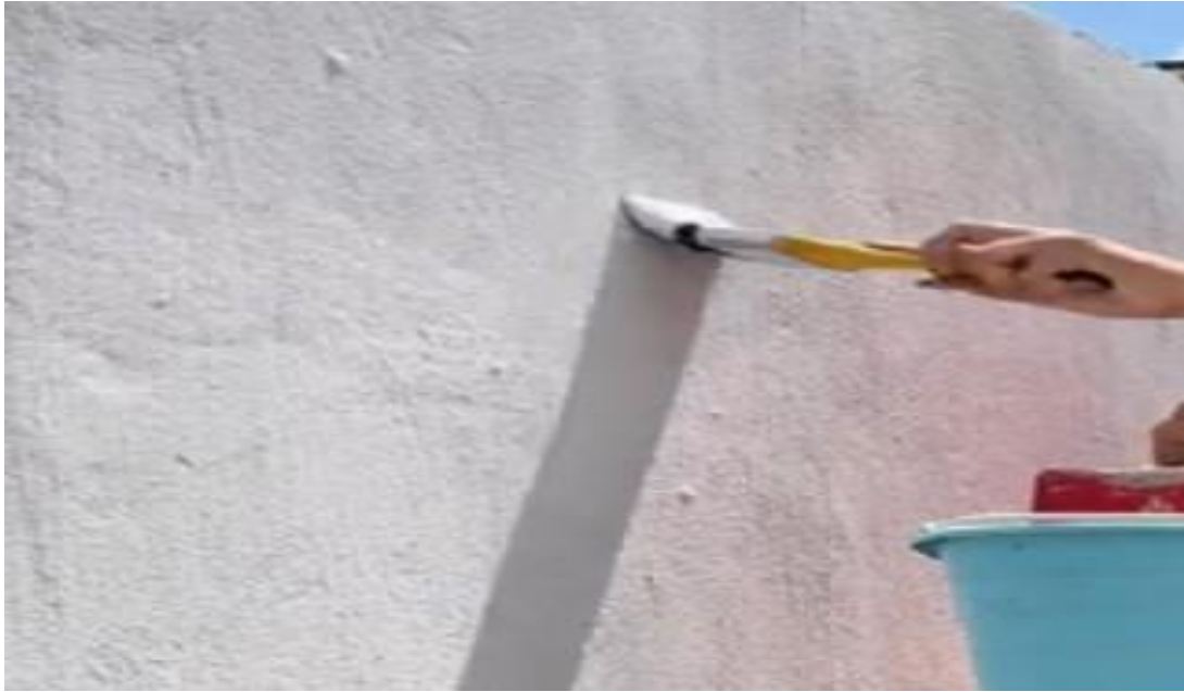
Figura 8. Pintura con sellador
